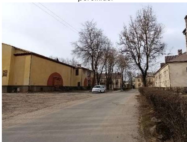
Vytauto skg. Matoma karpoma gyvatvorė palei Vytauto skg. 4., esami medžiai palei gatvę. Važiuojamosios dalies asfalto būklė gera, tik danga ties Vytauto g. 3 prasta.
