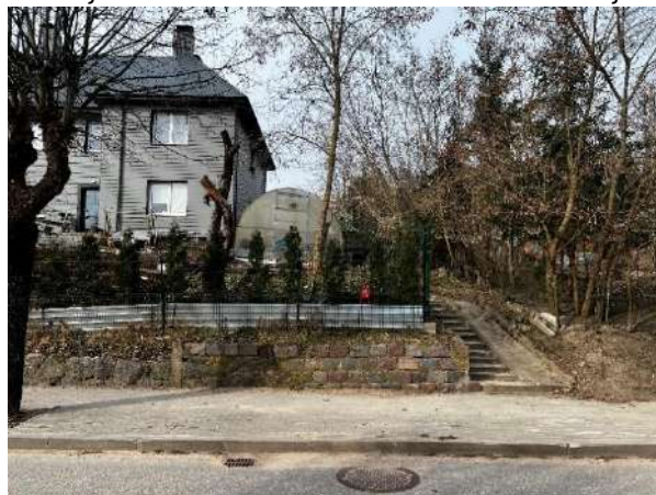
Laiptai su rampa tarp K. Būgos. 18 ir 20 namo jungiantys su K. Būgos gatve. Laiptų, rampos danga ir konstrukcija nusidevėjusi, nepritaikyta žmonėms su negalia.
