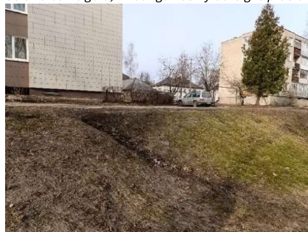
Matoma bloga asfalto danga pravažiavimo į kiemus ties Vytauto skg. 4. Kairėje puseje matoma sunykusią gyvatvorę. Dešinėje matoma, erozuojantį šlaitą dėl išleidžiamo lietaus vandens.
