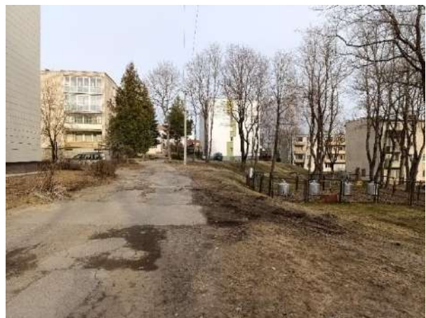
Matoma bloga asfalto danga pravažiavimo į kiemus ties Vytauto skg. 4. Kairėje puseje matoma sunykusią gyvatvorę. Dešinėje matoma, erozuojantį šlaitą dėl išleidžiamo lietaus vandens.
