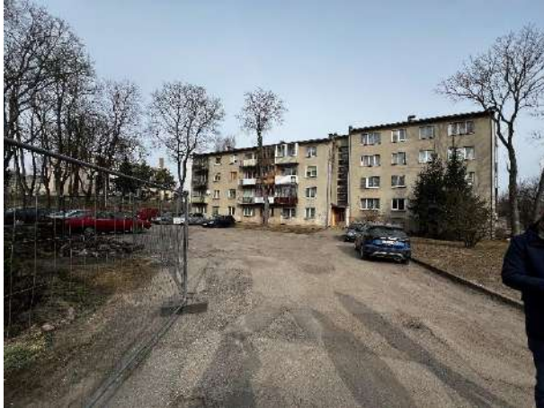
Esama kiemo dangų, želdinių padėtis tarp Vytauto skg. 10 ir Vytauto skg. 12. Matoma dalinai išlikusi kiemo buvusi struktūra. Kietos dangos nusidevėjusios. Nėra atkirti pėsčiųjų takai nuo važiuojamosios dalies. Esami medžiai auga greta pastato. Lietaus vanduo nuleidžiamas ant žaliųjų, kietųjų dangų.
