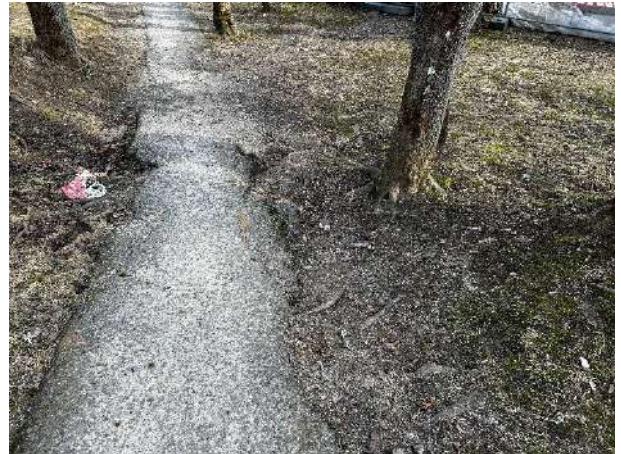
Esamas asfalto dangos takas praeinantis pro medžių grupę šlaite. Tako danga nusidevėjusi, medžių šaknys iškilnojusios konstrukciją, nėra pritaikyta aplinką visiems.
