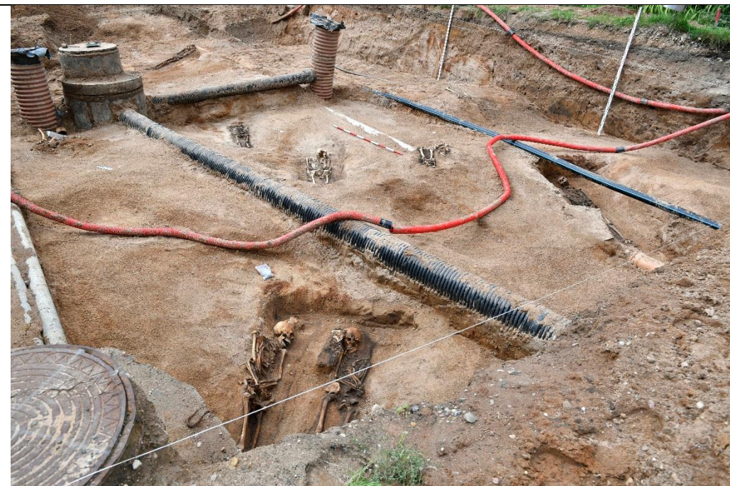
12. Perkasoje Nr. 5, 0,8–1,9 m gylyje atidengti kapai tarp esamų komunikacijų, vaizdas iš R
